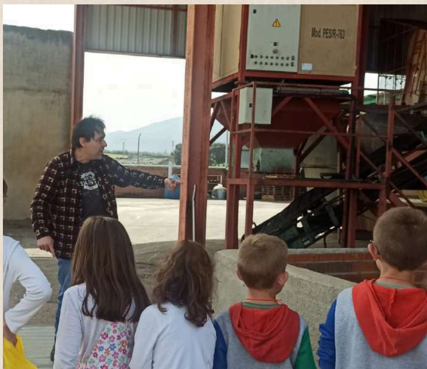
Tolvas, cintas, lavadora y pesadora de las aceitunas.
